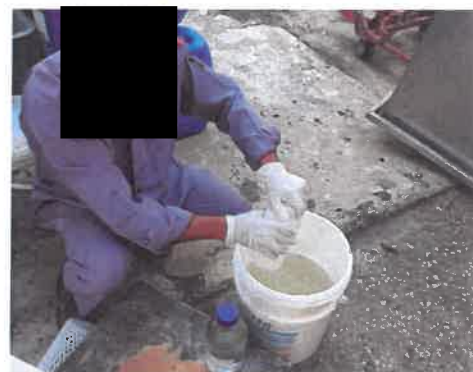
รูปที่ 2-10 การเก็บตัวอย่างน้ำจากระบบบำบัด
