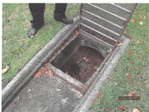
รูปที่ 2-11 บ่อตกตะกอนของรางระบายน้ำฝนที่ตกในพื้นที่ โรงแรม ก่อนระบายออกจากพื้นที่
