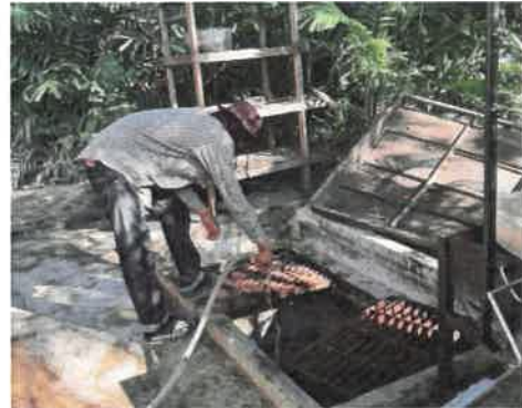
รูปที่ 2-2 การดูดไขมัน จากบ่อดักไขมันไปกำจัด
